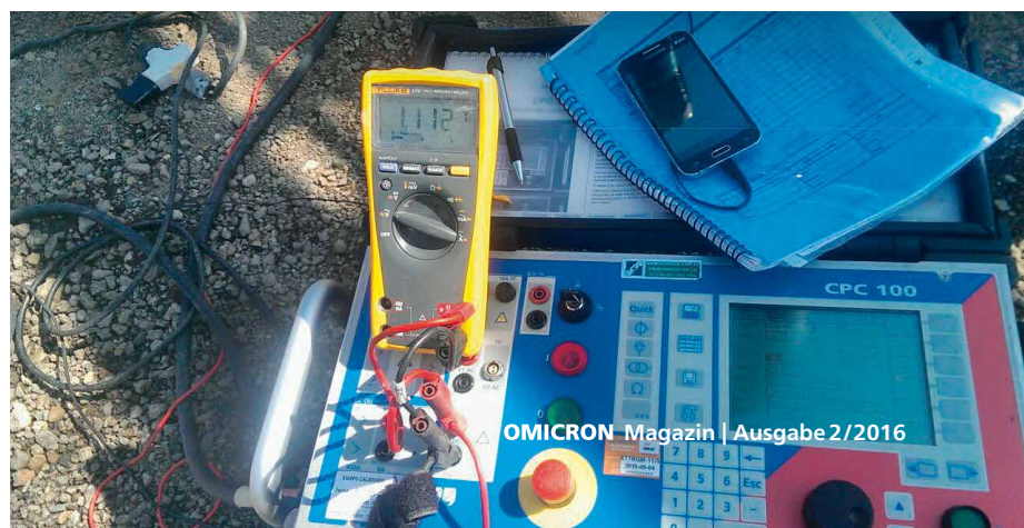
Bild 2: Für die Prüfung werden nur ein ▶ CPC 100, ein Voltmeter und ein Zangenamperemeter eingesetzt.
