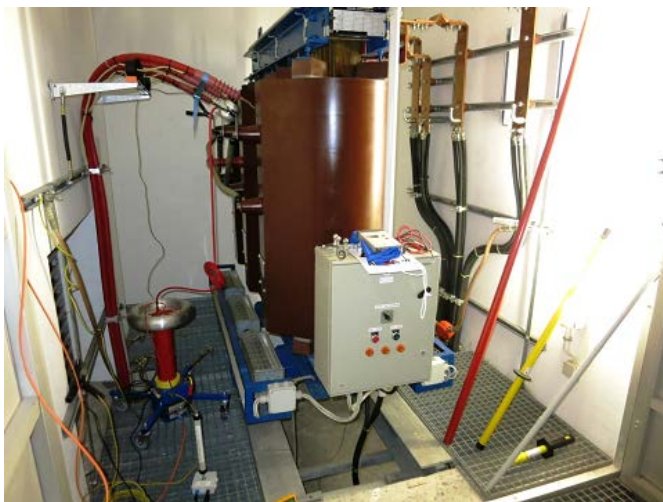
Abbildung 9. Prüfanordnung der TE-Messung an einem 20-kV-/2-MVA-Gießharztransformator
