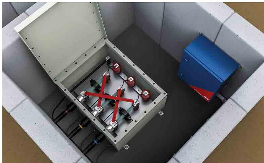
Las cajas de cemento protegen los sensores de HFCT y la unidad de registro de datos contra el agua subterránea y el polvo.
