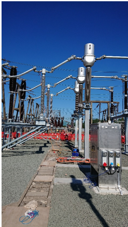
Abb. 7: Prüfung mit dem CPC 100, in der der Prüfstrom durch einen konventionellen und durch einen nicht konventionellen Wandler getrieben wird
