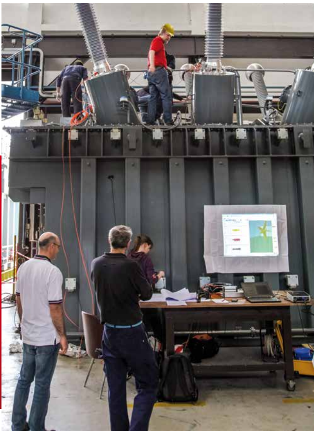
Proyección del análisis de fallas en la cuba del transformador.
