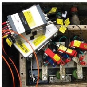
Beispiel für die Verwendung eines HFCT an einer Crossbonding-Box
