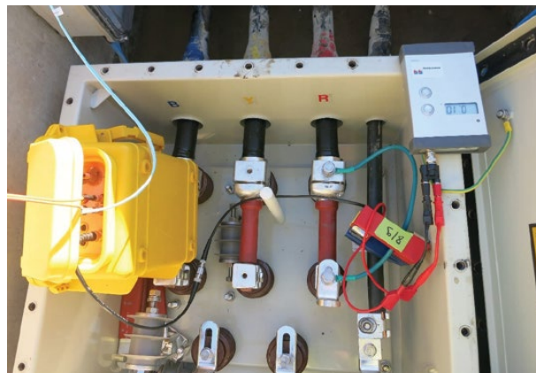
Подключение внутри коробки заземления с транспозицией экранов
