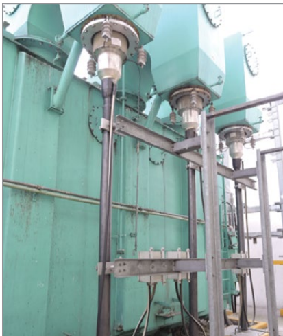
Концевые муфты системы с коротким кабелем 230 кВ
