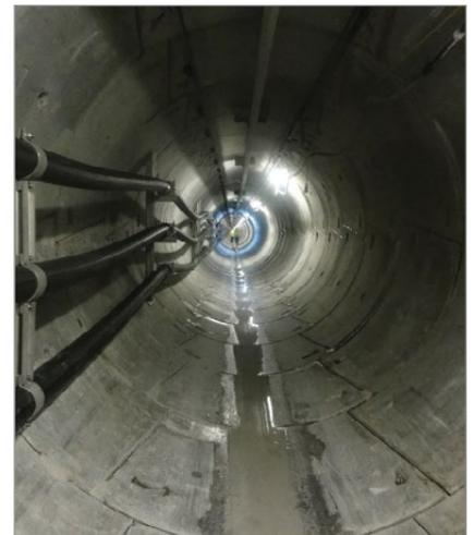
Соединительные муфты кабельной системы 380 кВ, проложенной в туннеле
