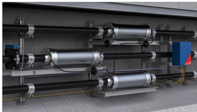
Мониторинг ЧР на транспозиционных муфтах кабельной системы, проложенной в туннеле
