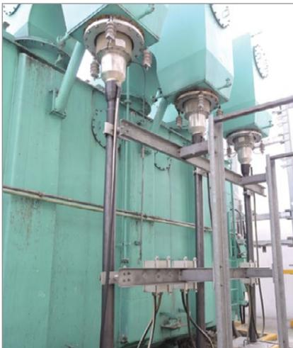
Концевые муфты системы с коротким кабелем 230 кВ
