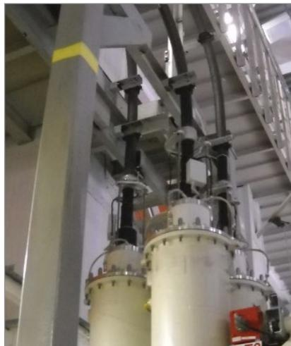
Концевые муфты кабельной системы 380 кВ, проложенной в грунте
