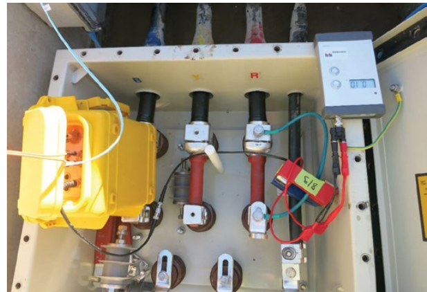
Verbindung im Schaltkasten der Auskreuzverbindungen
