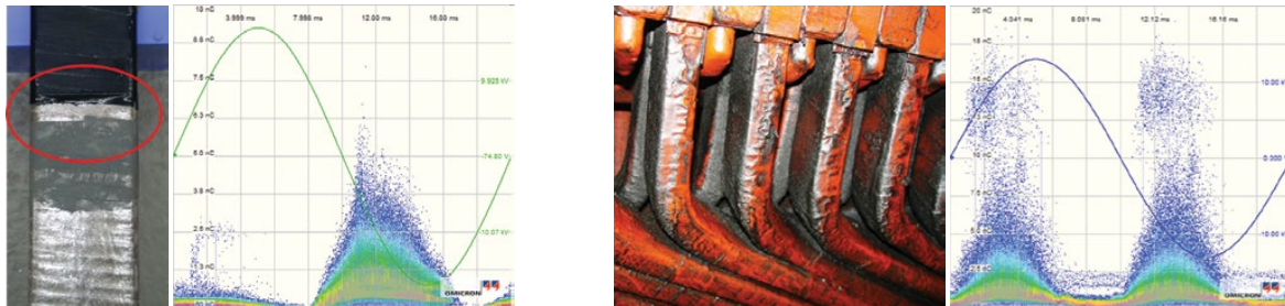
Figura 3: Posibles problemas en un sistema de aislamiento de una máquina rotativa con un diagrama PRPD correlativo. La causa izquierda representa una compensación de potencial final desconectada de la protección anticorona exterior. La de la derecha representa una zona de devanado final contaminada y las superficies resultantes, así como las descargas entre fases.
