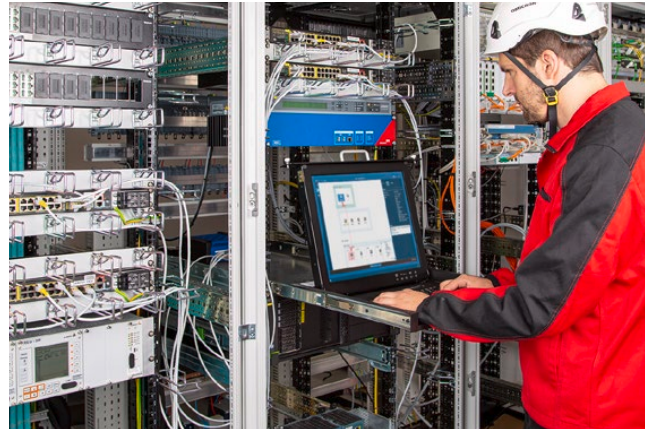
Figure 3 : StationGuard importe le fichier SCL (System Configuration Language) du poste afin de créer un modèle de système complet
