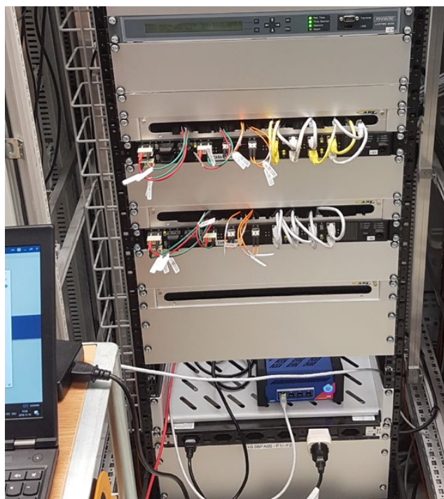
Figure 4 : Installation pilote sur un poste de 110 kV de CKW
