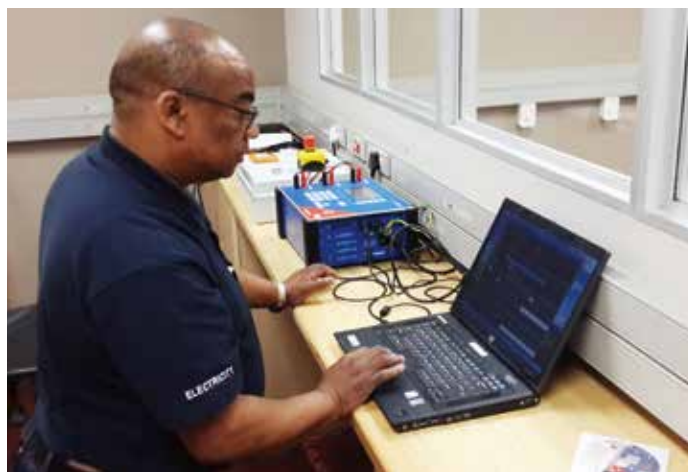
Keith Daniels von der Metropolgemeinde Kapstadt bei der Kalibrierung von Spannungs- und Stromwandlern mit VOTANO 100 und dem CT Analyzer.
