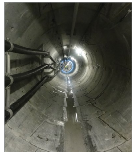
Empalmes de un sistema de cables tendidos en túneles de 380 kV
