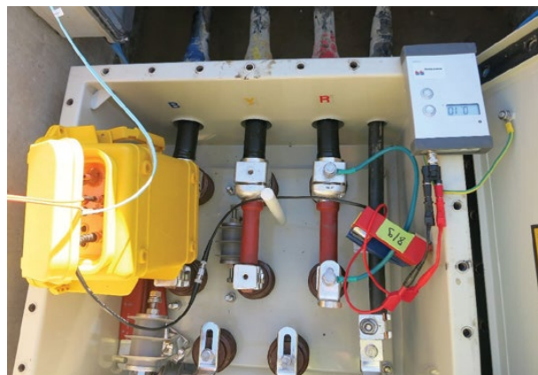
Connexion à l'intérieur du boîtier de liaisons de permutation
