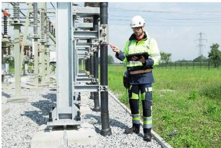
Mesures des tensions de pas et de contact rapides et faciles avec le HGT1 et le logiciel PTM
