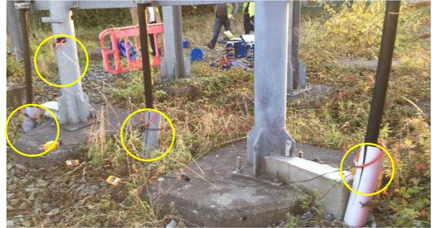
Figura 14: Medición primaria de  $I_p$  con 4 bobinas Rogowski
