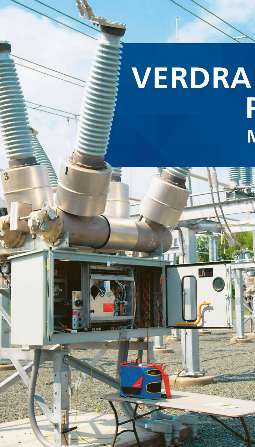
Die richtige Polarität der Spannungs- und Stromwandlerpfade sind eine Grundvoraussetzung für die korrekte Funktion der angeschlossenen Schutzrelais. Distanzschutzrelais nutzen die Messwerte beispielsweise, um zu erkennen, ob der Fehler in Vorwärts- oder Rückwärtsrichtung liegt. Eine falsche Polarität kann daher mitunter eine fatale Fehlentscheidung nach sich ziehen und in Folge zu Ausfällen führen.
