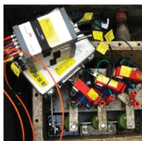
Пример использования HFCT в ящике для транспозиции экранов
