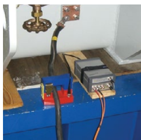
Установка HFCT на кабеле заземления силового трансформатора
