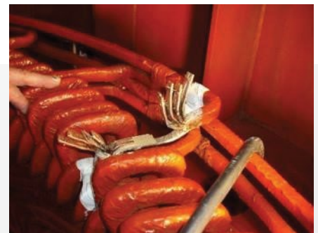
Reparatur der defekten Lötstelle
