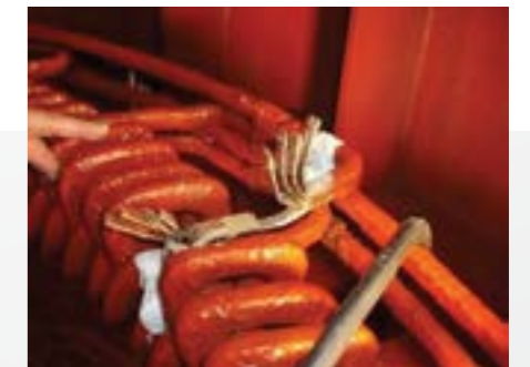
修复有缺陷的焊接点
