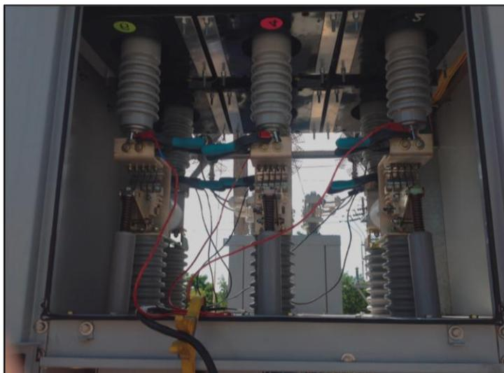
*Figura 16 – Cables colocados directamente en las botellas de vacío.*
