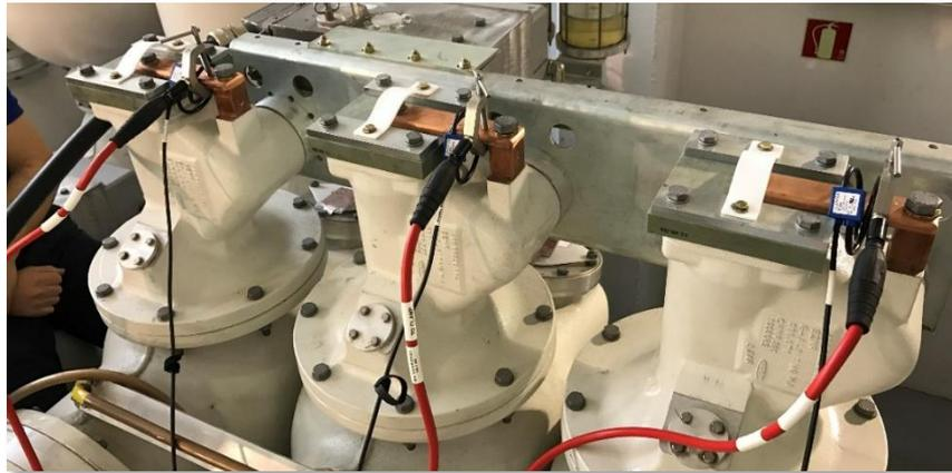
Figura 17 - GIS 245 kV con tres envolventes, una para cada fase.
