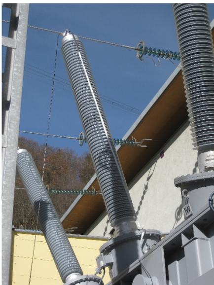
Figura 7: Ejemplo del concepto de conexión de trenzado más corto
