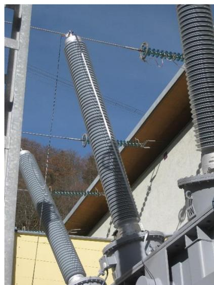
Figure 6 : Exemple de concept de connexion par tresse la plus courte : les câbles de mesure (noirs) sont connectés à la borne de traversée et la tresse de mise à la terre à la borne et à la bride de traversée
