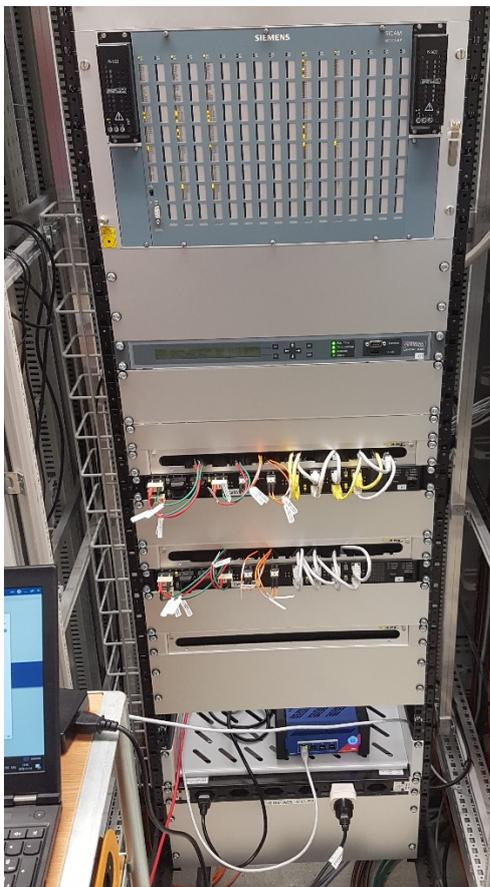
Figure 3 Installation dans un poste de 110 kV de CKW à l'aide de la variante de plate-forme mobile de StationGuard
