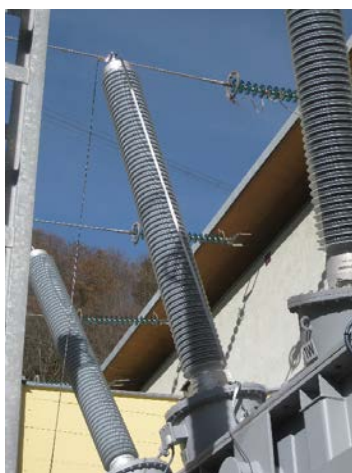
Abbildung 7: Anschlussbeispiel nach dem Prinzip „kürzest möglicher Erdungsbänder“
