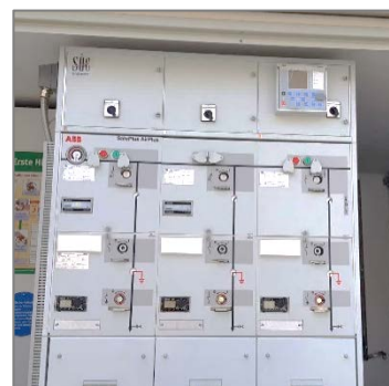
Figura 6 Aparata de 20 kV SafeRing AirPlus de ABB
