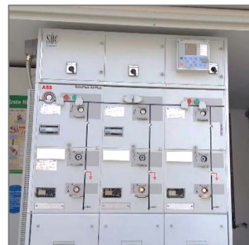
Bild 6 ABB SafeRing AirPlus 20-kV-Schaltanlage
