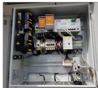
Bild 5 Fernmeldung und Steuerung über ABB FIONA
