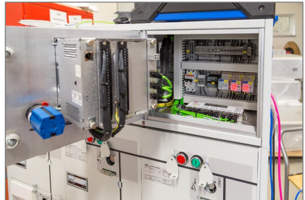
Bild 8 ABB Sensortestadapter in der Niederspannungsnische
