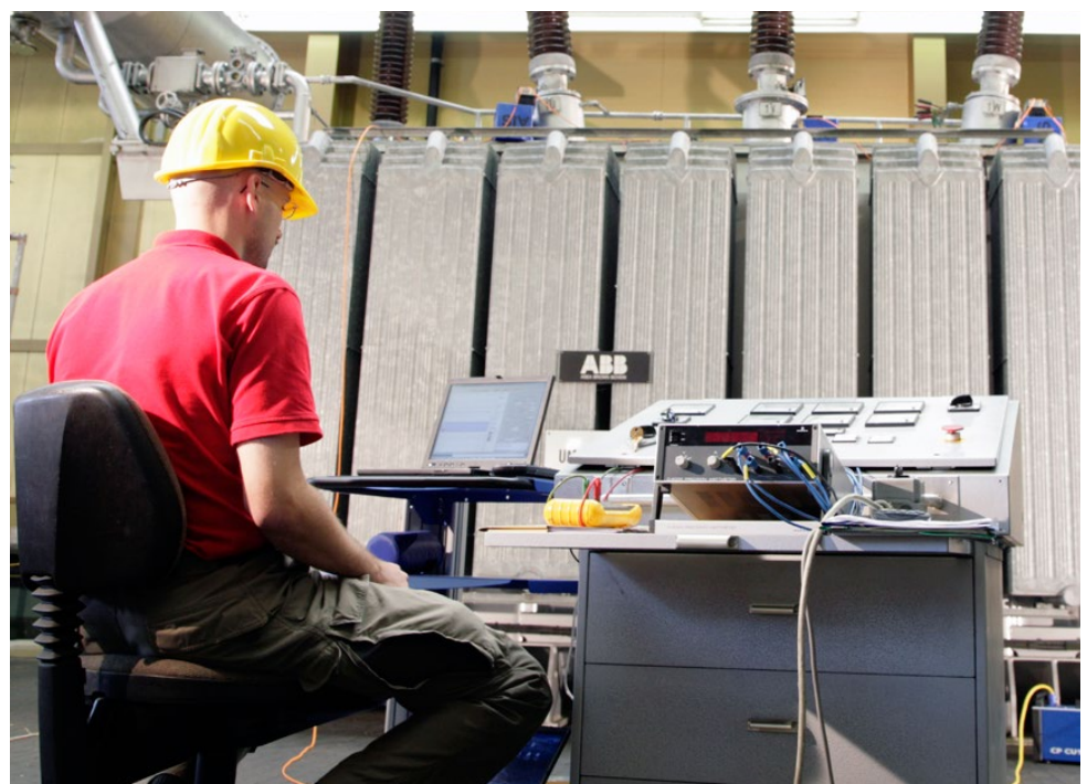
Diagnóstico de descarga parcial del transformador
